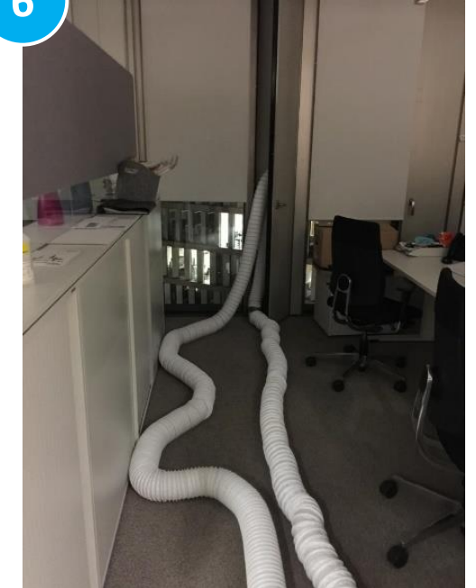
Dichtstoff wird über Bypass aus dem Bürogebäude geleitet
