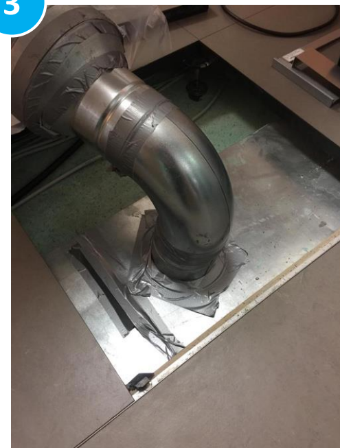
Zugang über Wickelfalzrohr
